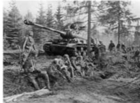
Тяжелые танки нового поколения ИС ("Иосиф Сталин") пришли на смену мощным КВ ("Клим Ворошилов"), появившимся еще до войны. Хорошее бронирование и приличные ходовые качества были дополнены мощнейшим 122-мм орудием, беспрецедентным для танков того времени. С ИСами Красная Армия вошла в Берлин. На вооружении Советской, а потом и Российской Армии эти танки стояли до 1995 года.
